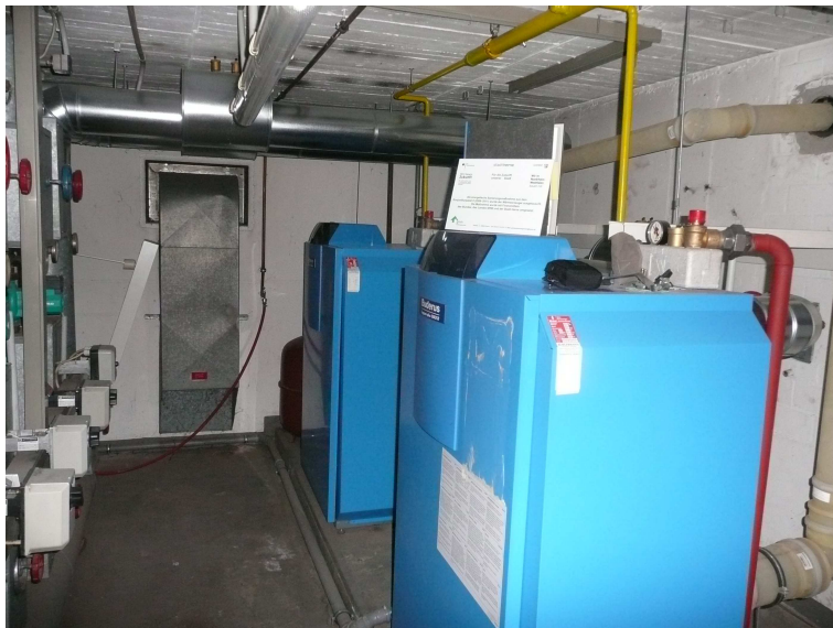
2 Gas – Brennwertkessel Fabrikat Buderus: Typ Lugano Plus SB 312
