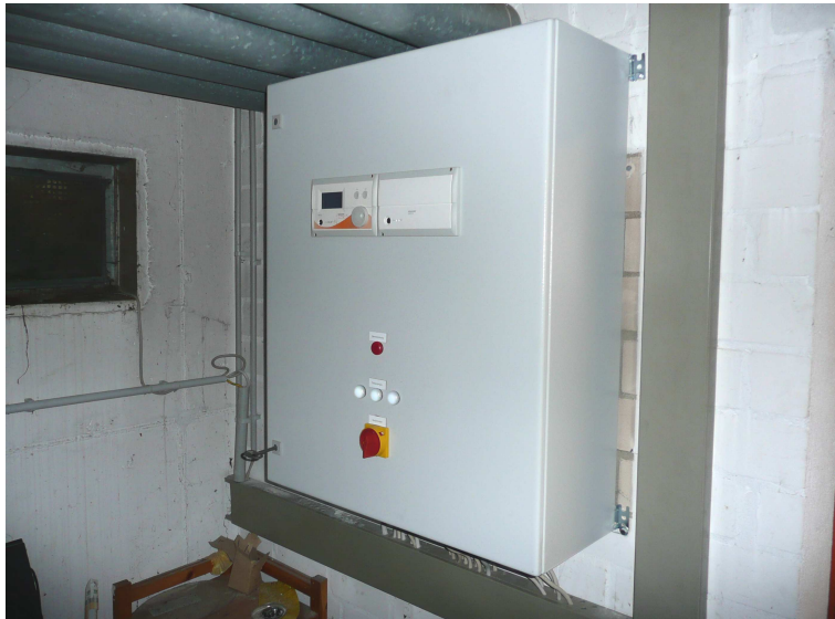
Schaltschrank mit digitalen Regelgeräten Fabrikat: Kieback & Peter Typ: HRP 22 und HRP 24 für 4 Regelkreise
