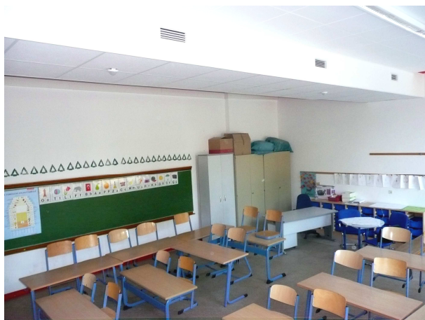
Lüftung Klassenzimmer GS Laurentius
