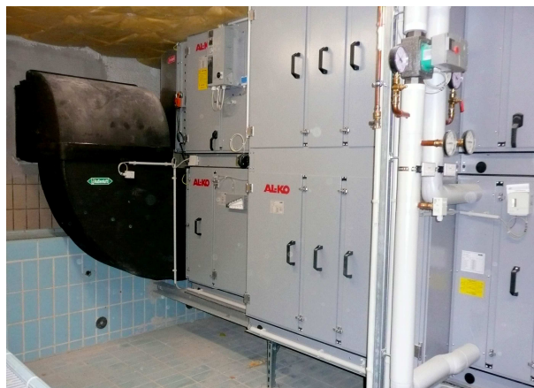
Lüftungszentrale GS Laurentius
