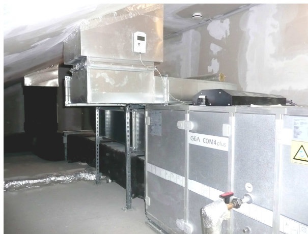
Lüftungszentrale KiTa Florastraße
