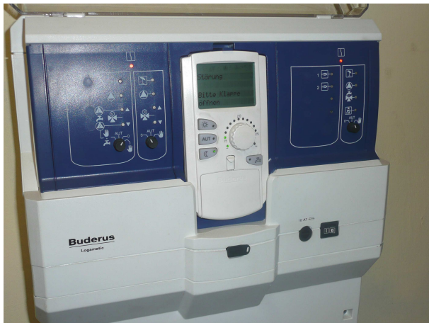
Regelgerät Fabrikat: Buderus Typ: Logamatic Heizkreisregler für 2 Heizkreise
