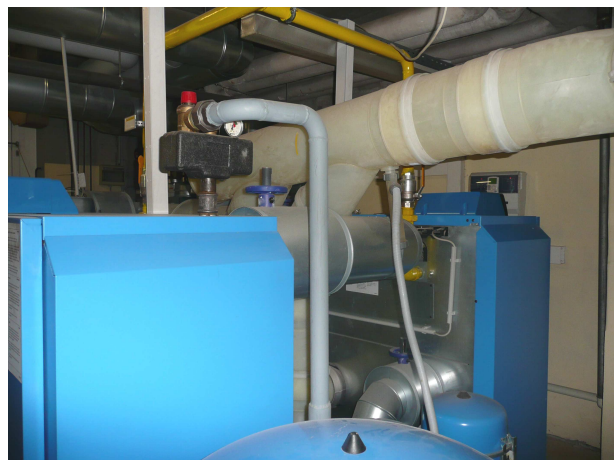
Zwei Gas – Brennwertkessel Fabrikat: Buderus
