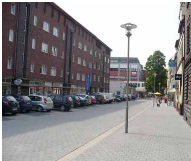
Die Umgestaltung in der Wanner Straße wurde in zwei Bauabschnitte unterteilt. Mit dem Abschluss der Maßnahmen zwischen Wibel- und Hauptstraße im Sommer 2012 weist die neue Wanner Straße auf ihrer gesamten Länge jetzt ein einheitliches und attraktives Bild auf.
