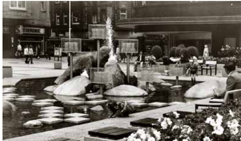
Buschmannshof um 1970: Die großzügige Brunnenanlage ist Attraktion und Anziehungspunkt auf dem Buschmannshof und verkörpert die ‚Moderne‘ in der alten Bergbaustadt Wanne-Eickel.
