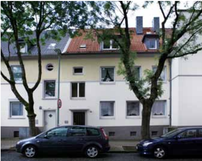
Die Immobilie Freisenstraße 32 vor und nach der Sanierung.
