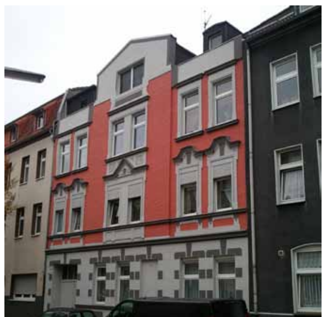
Die Immobilie Deutsche Straße 11 nach der Sanierung.
