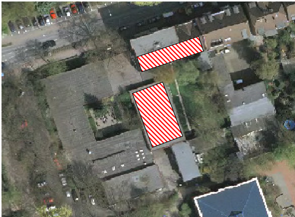
Abbildung 2: Hauptgebäude und Altbau
