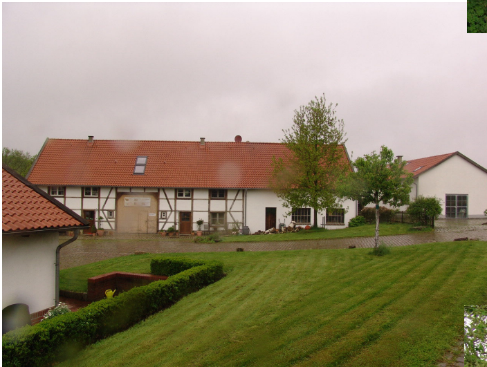
Die Fassaden der ehemaligen Scheune (links) und des Schweinestall (rechts) sind komplett renoviert
