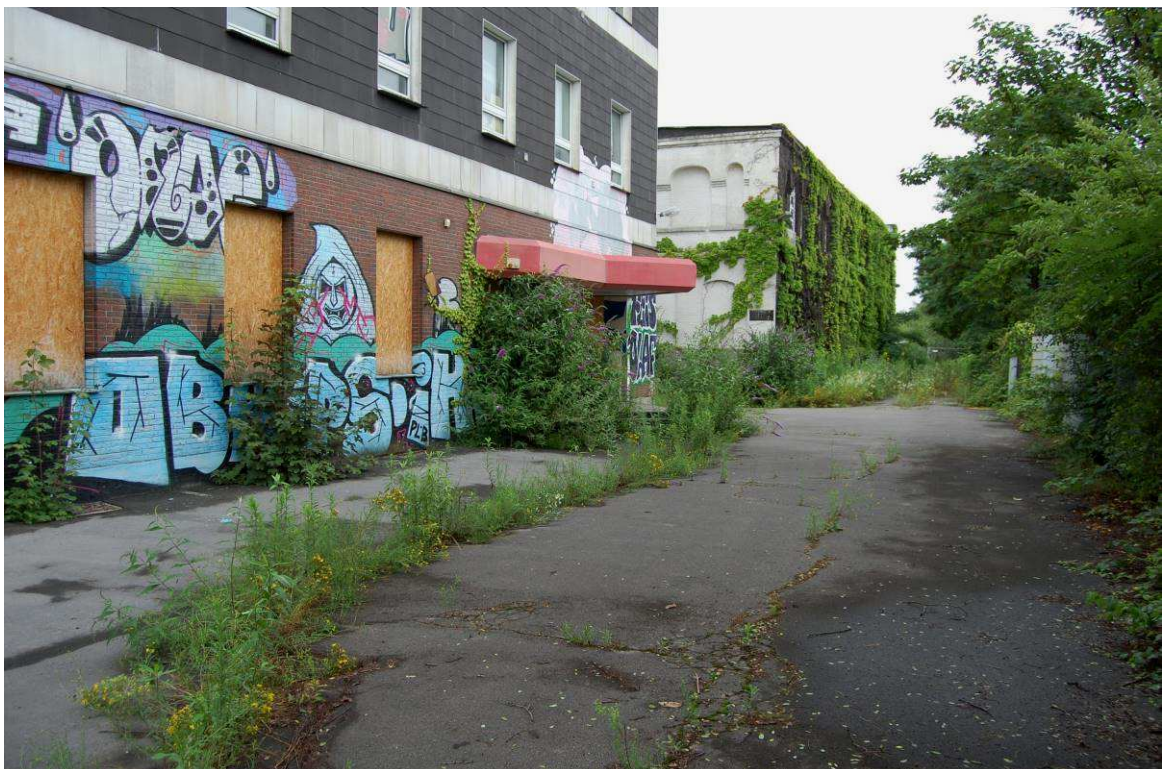
Abbildung 21: Südliche Grenze des Bebauungsplangebietes/Bestandsgebäude (ehemaliges Textilunternehmen)
