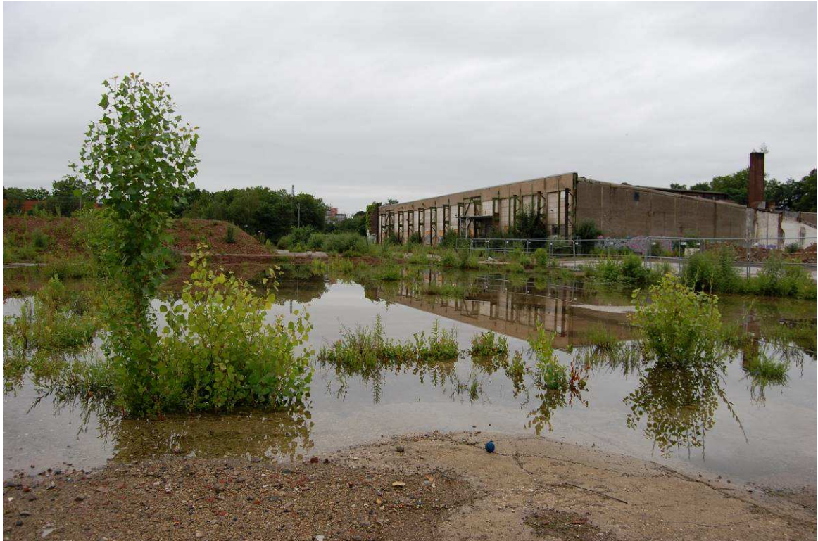
Abbildung 08: Rückbauflächen/Wasserlache nach Starkregenereignissen -Juni 2021- (Blickrichtung: Süden)
