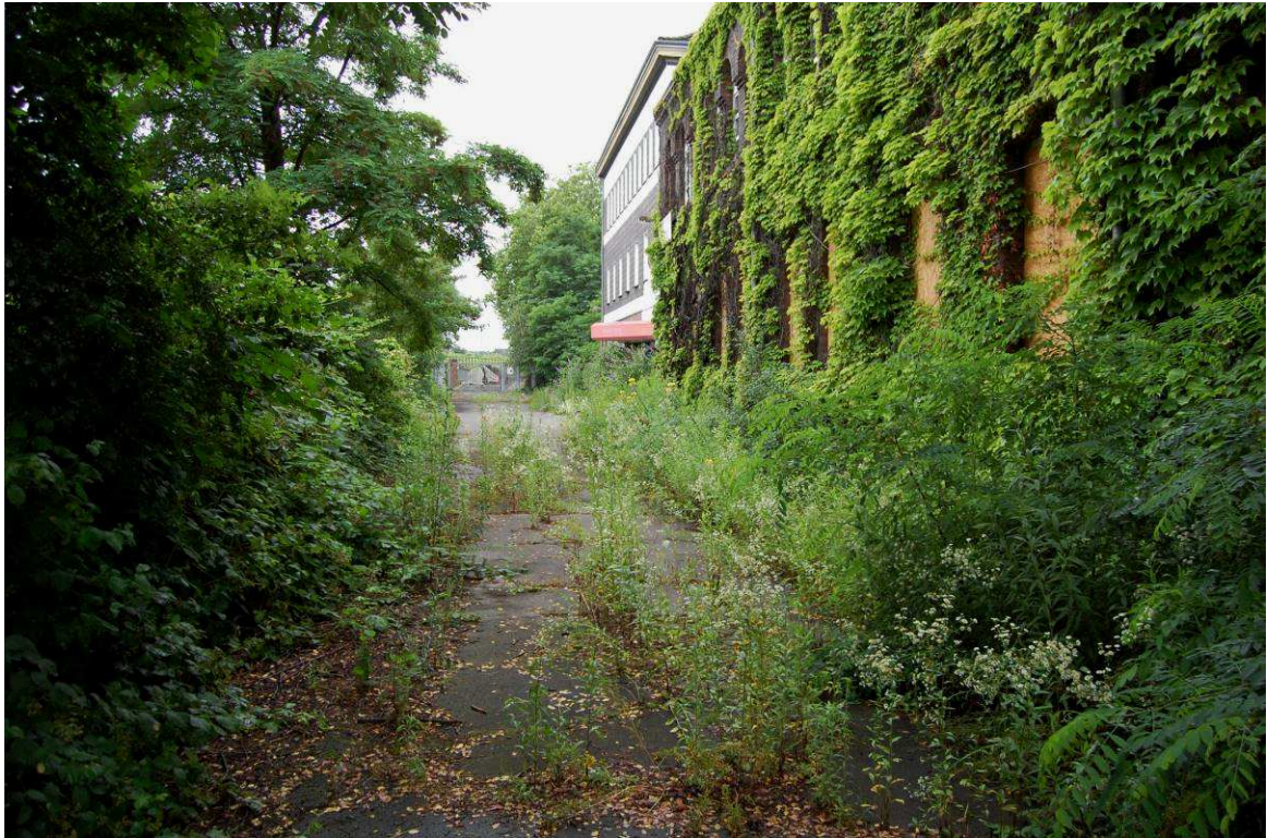
Abbildung 22: Bestandsgebäude (ehemaliges Textilunternehmen)
