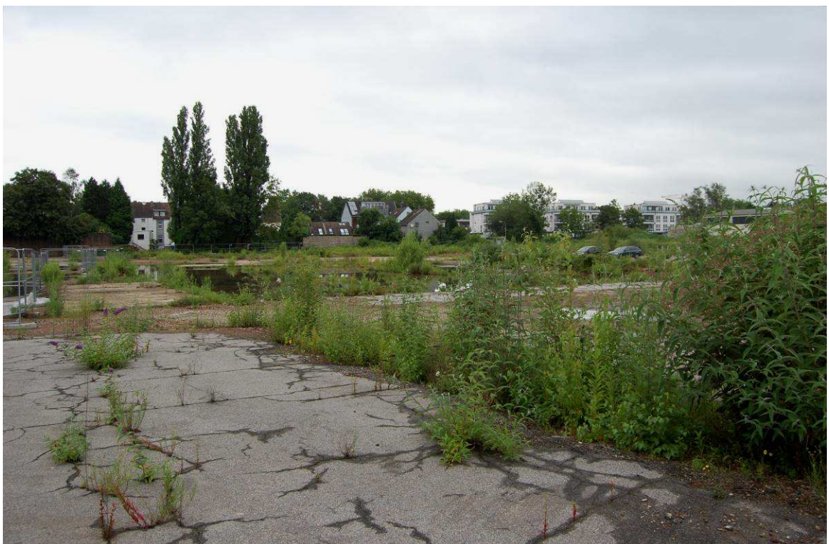
Abbildung 05: Rückbauflächen/Bestandsgebäude an der Eschstraße/Schüchtermannstraße (Hintergrund)
