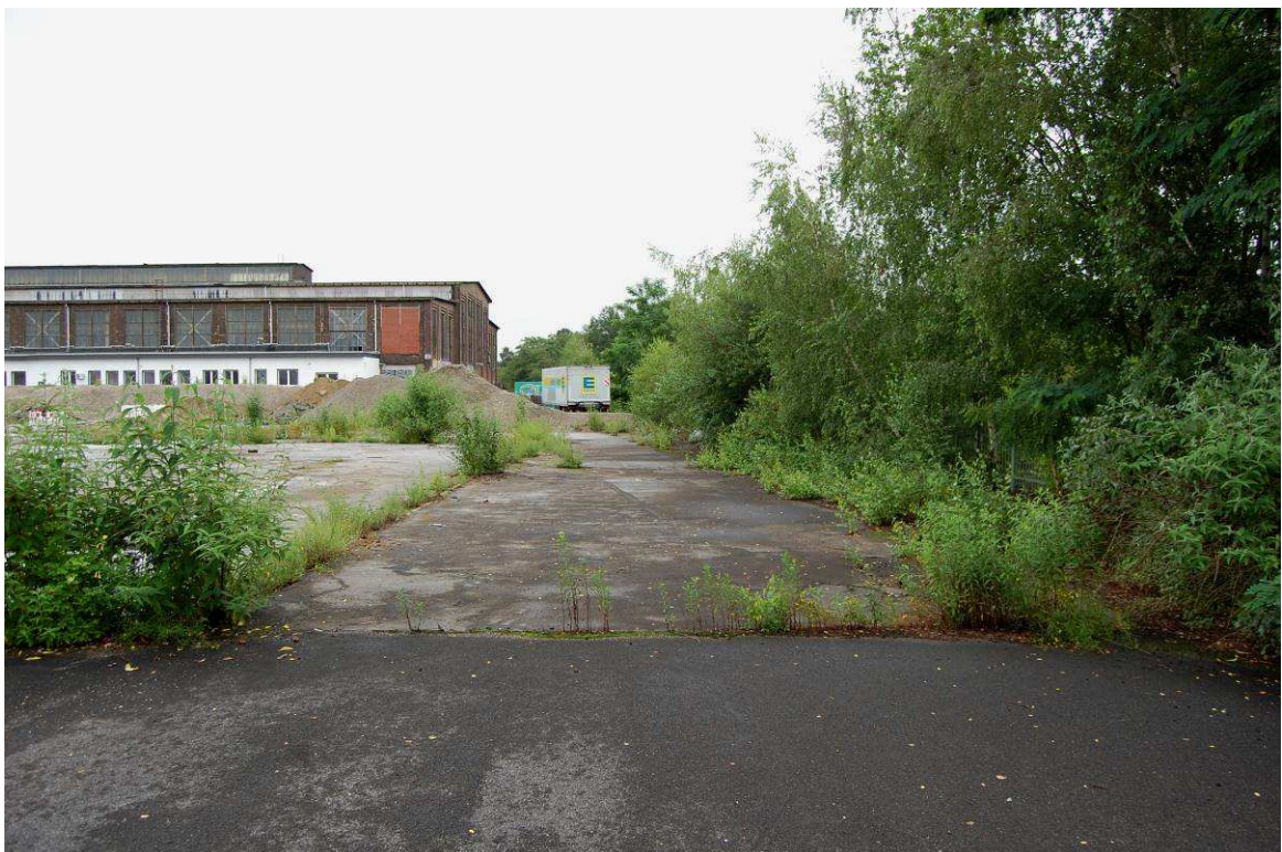
Abbildung 15: Bestandsgebäude/Gehölzstreifen an Gleistrasse (östliche/südliche Grenze des Bebauungsplangebietes)
