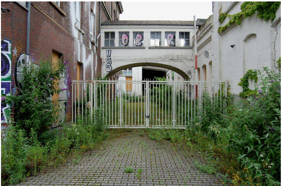
Abbildung 23: Bestandsgebäude (ehemaliges Textilunternehmen)
