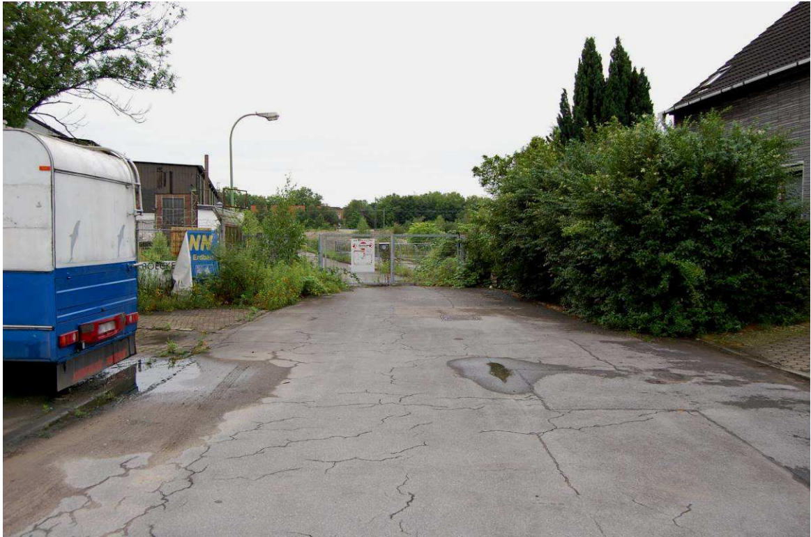
Abbildung 18: Fabrikstraße ; östliche Grenze des Bebauungsplangebietes (Blickrichtung: Süden)
