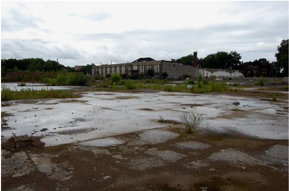
Abbildung 10: Rückbauflächenkurz nach Starkregenereignissen -Juni 2021- (Blickrichtung: Süden)
