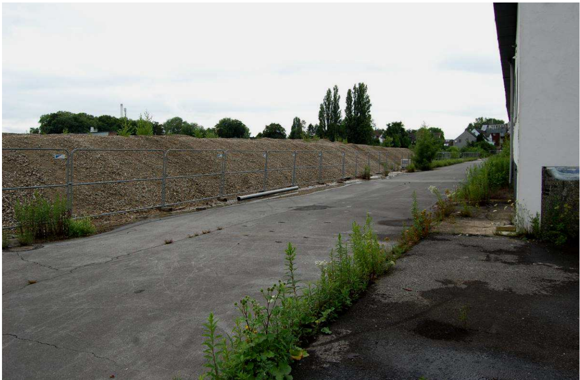
Abbildung 19: Fabrikstraße ; Bestandgebäude/Rückbaumaterial-Miete (Blickrichtung: Nordwesten)
