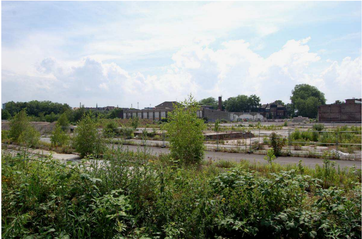
Abbildung 04: Rückbauflächen/Bestandsgebäude an der Baumstraße (Hintergrund)
