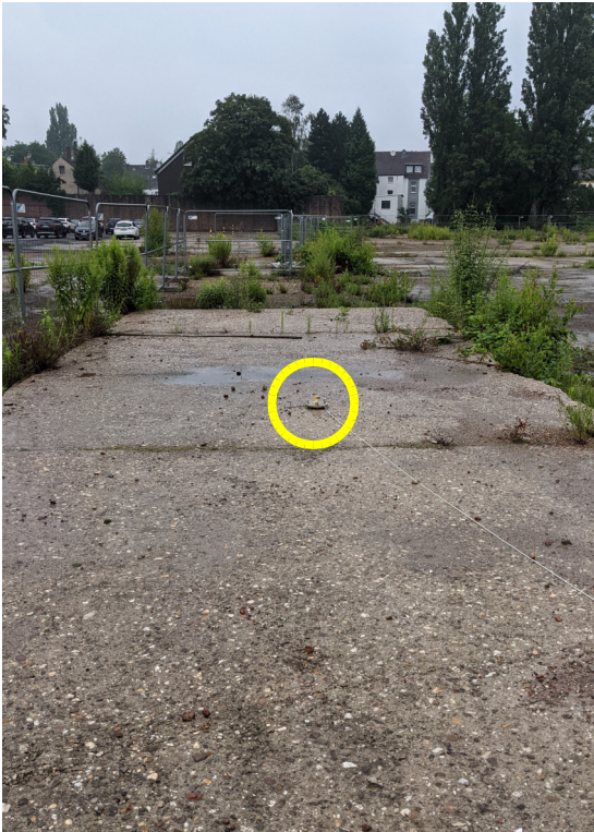
MP 5, auf Fundamentrest – 120 m
