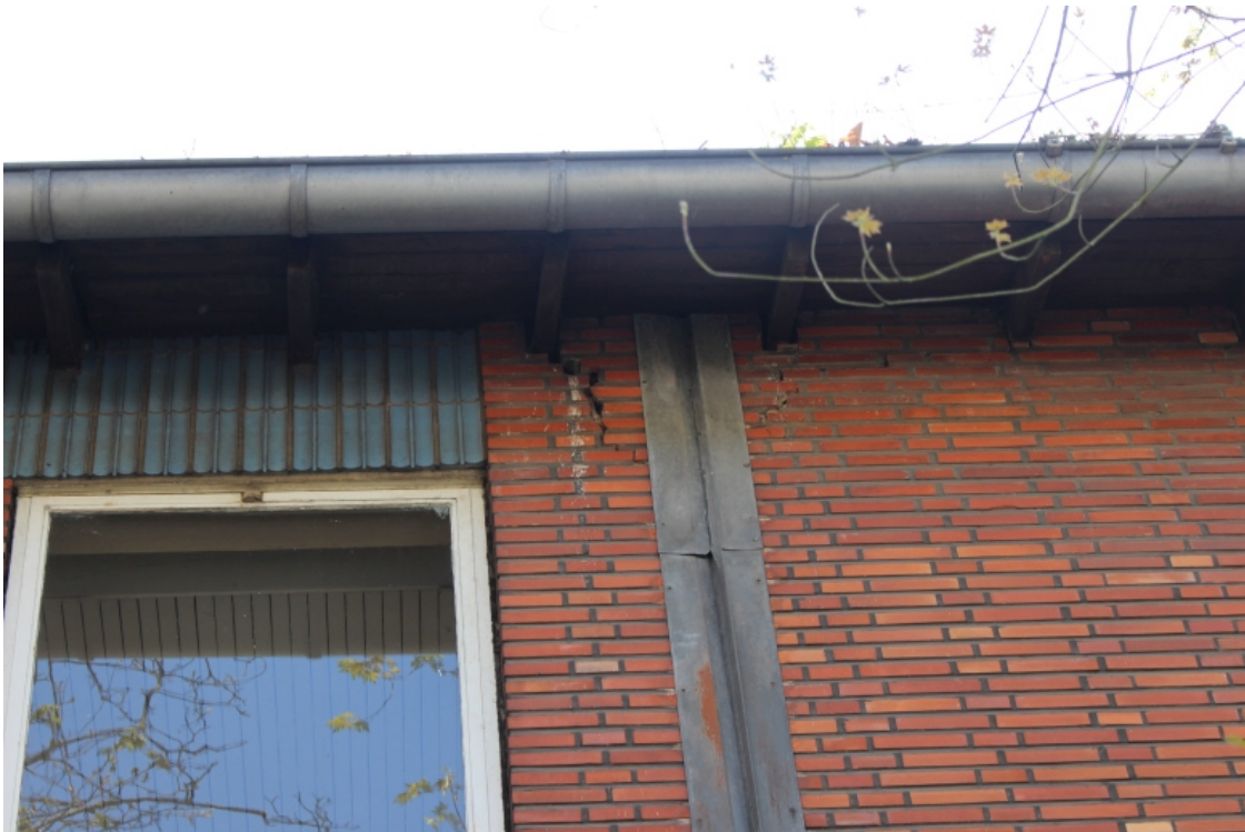
Spaltensysteme durch Gemäuerrisse.
