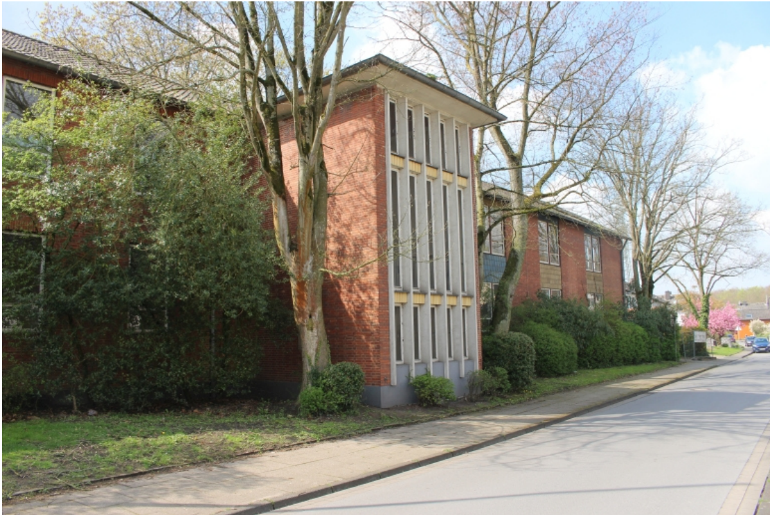
Nordseite des Schulgebäudes an „Grimberger Feld“.
