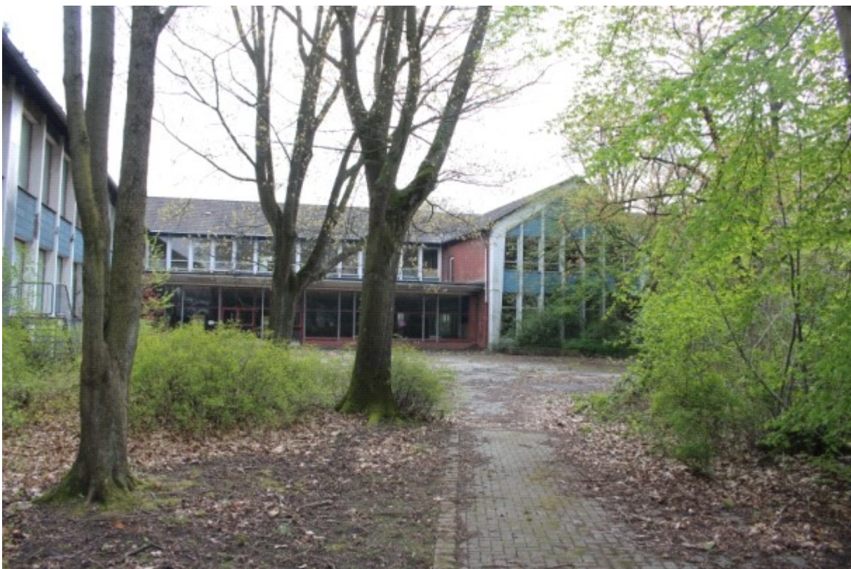
Horchboxstandort West, gebäudenah unter dem Giebel (rechte Bildmitte)
