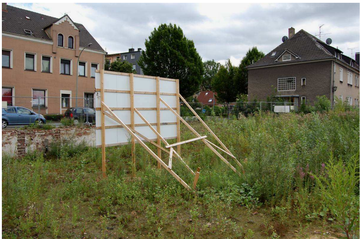
Abbildung 07: Abbruch-/Baugrundstück; Wohngebäude 'Kirchstraße 55/64' (Hintergrund)
