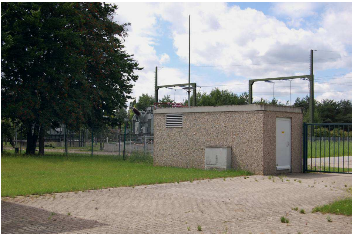
Abbildung 23: Gebäude des Umspannwerkes; Rasenfläche/Einzelbäume an der westlichen Flurstücksgrenze
