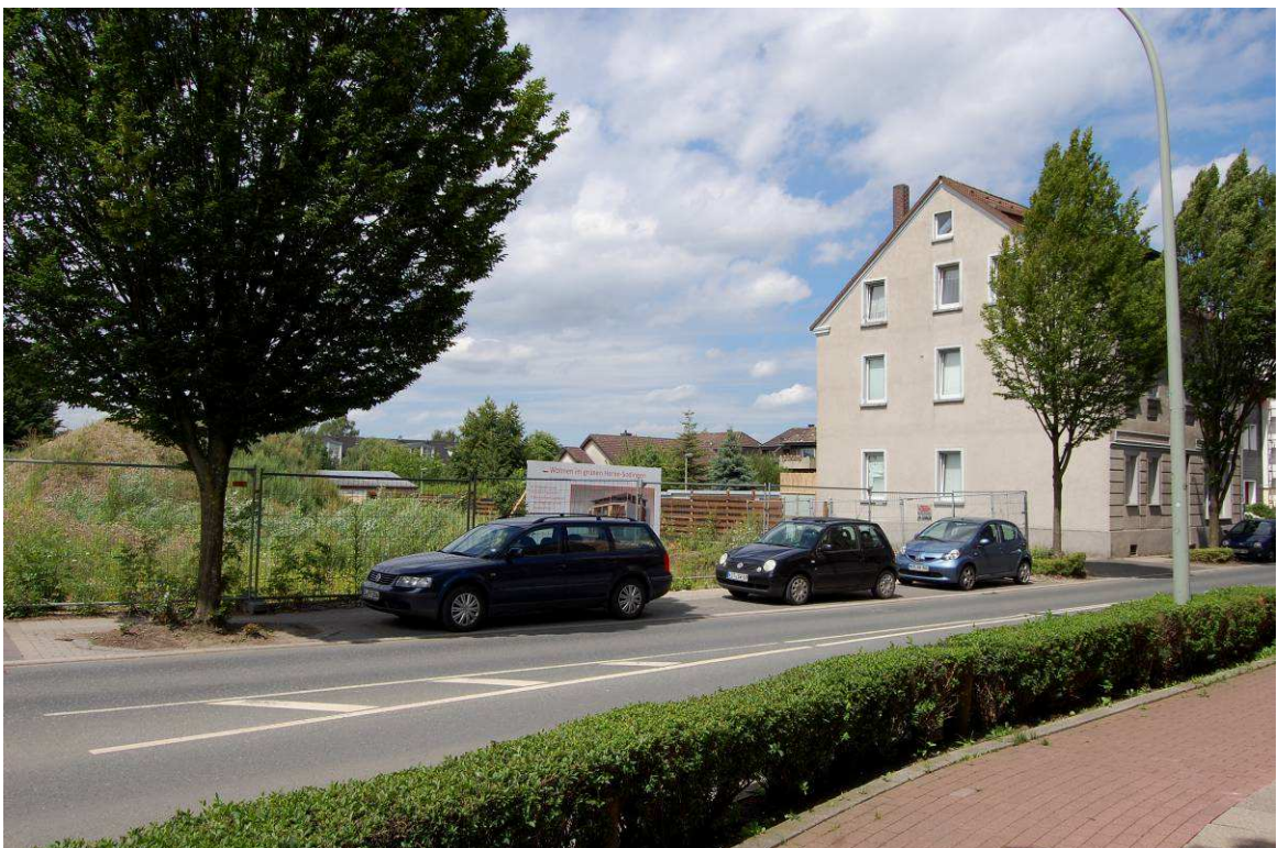
Abbildung 03: Kirchstraße; Abbruch-/Baugrundstück (ehem. Wohngebäude "Kirchstraße 57" (Südostansicht)
