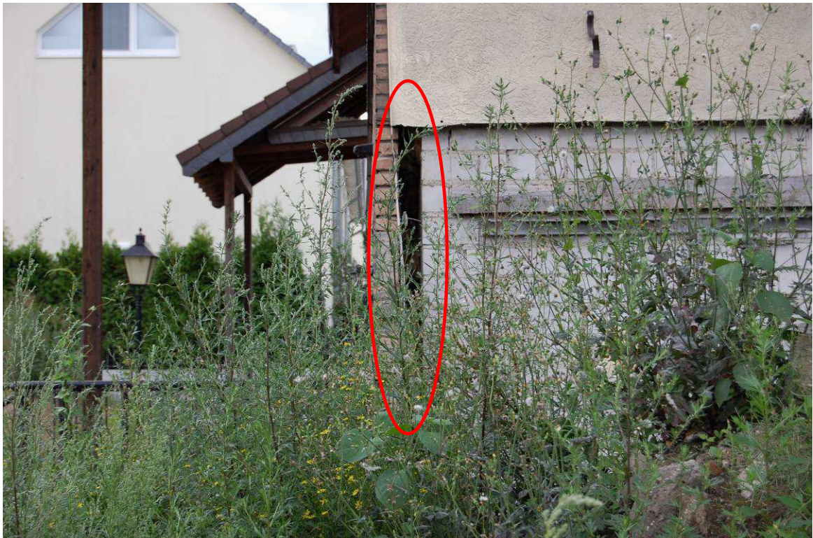
Abbildung 12: Vormauerschale am Wohngebäude 'Kirchstraße 57a' (Ellipse); potenzielles Fledermausquartier
