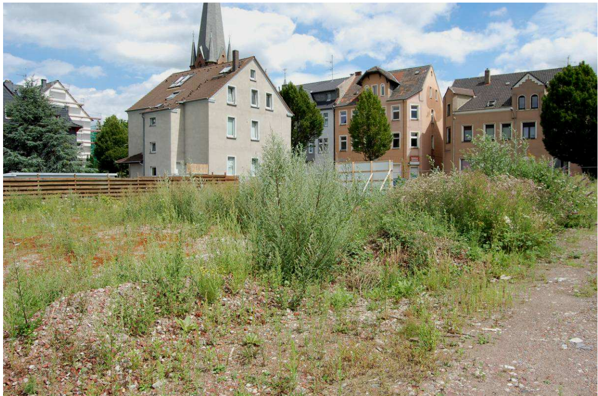
Abbildung 06: Abbruch-/Baugrundstück (ehem. Wohngrundstück/Wohngebäude "Kirchstraße 57")
