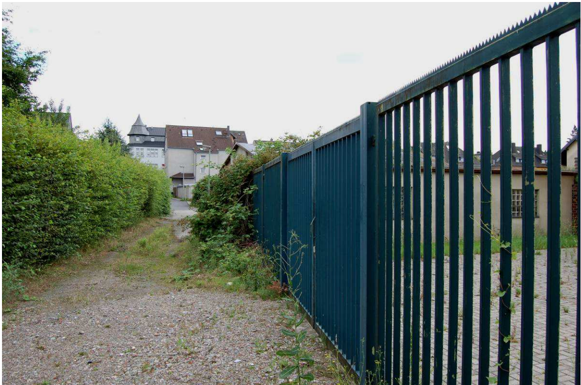
Abbildung 20: Zufahrt zum Grundstück des Umspannwerkes; Wohngebäude 'Kirchstraße 59' (Hintergrund)
