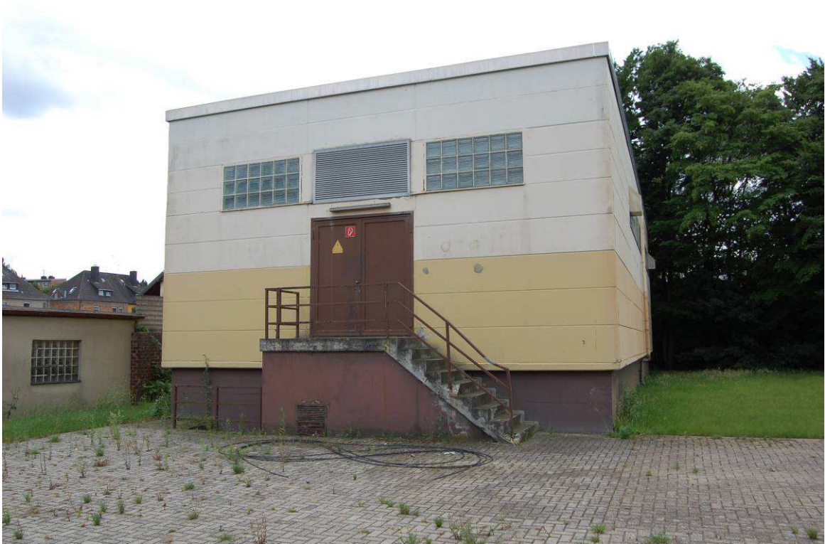
Abbildung 22: Gebäude des Umspannwerkes; Einzelbäume/angrenzende Gehölzbrache an der Grundstücksgrenze
