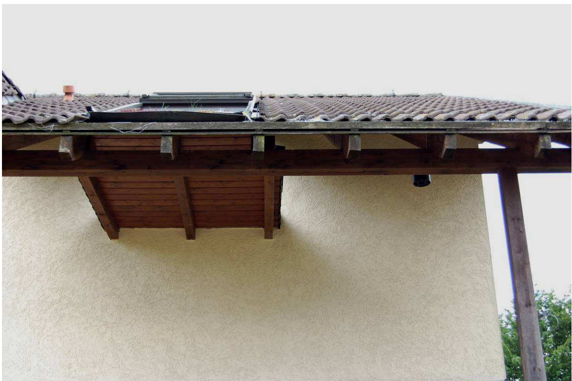
Abbildung 13: Dachtraufe des Wohngebäudes 'Kirchstraße 57a'; potenzielle (zukünftige) Fledermaus-/Schwalbenquartiere
