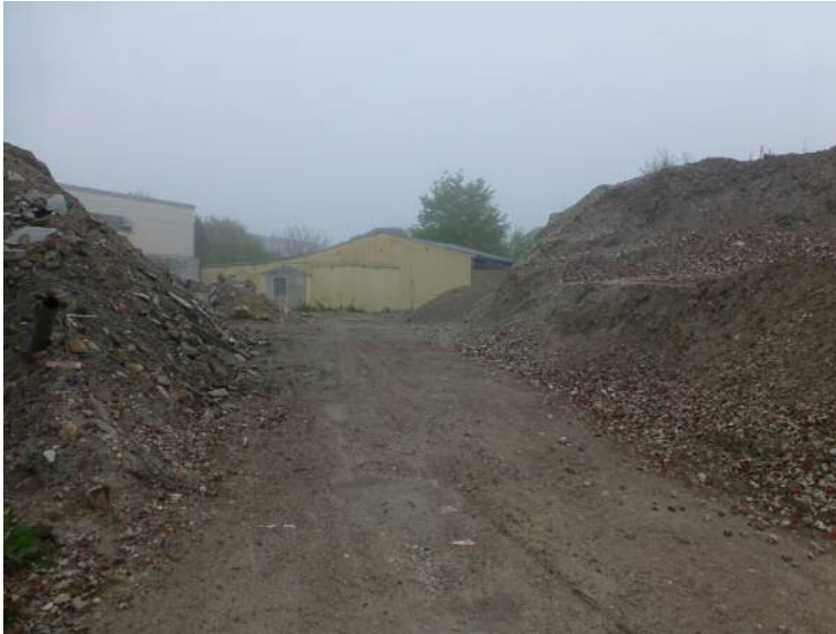
Abbildung 3: Blick in nördliche Richtung, links und rechts Haufwerke aus den Abbrüchen
