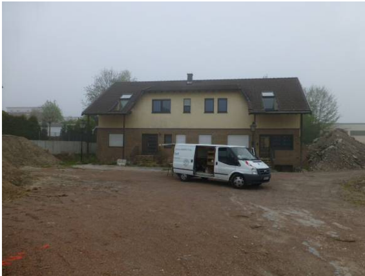
Abbildung 1: Blick auf den noch vorhandenen Teil der Liegenschaft Kirchstraße 57a
