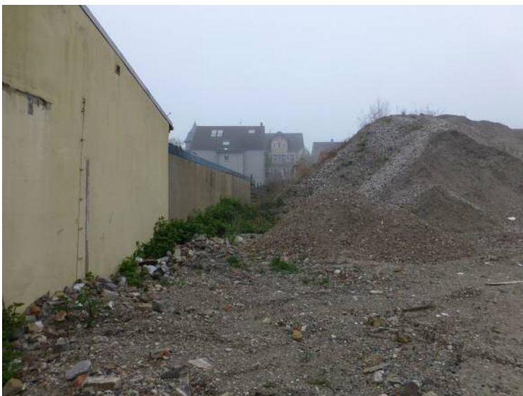
Abbildung 4: Blick in östliche Richtung, Bereich Bohrung B E
