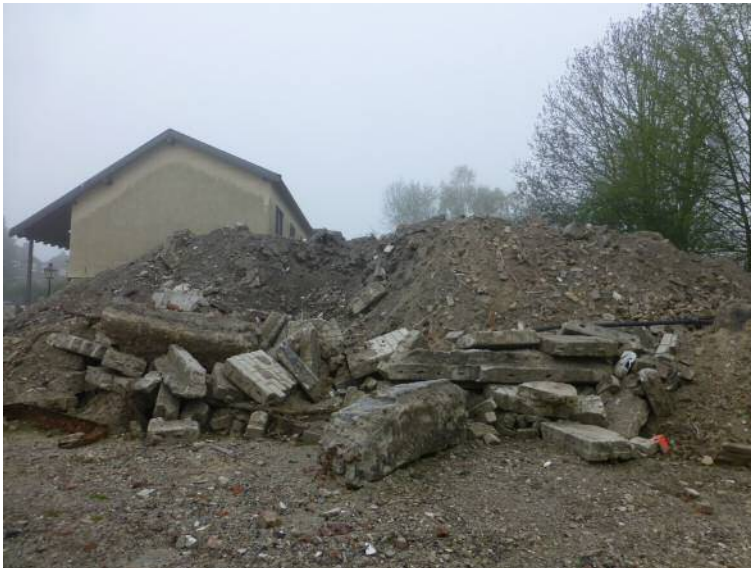
Abbildung 5: Blick auf Haufwerk, im Hintergrund das Objekt Kirchstraße 57a
