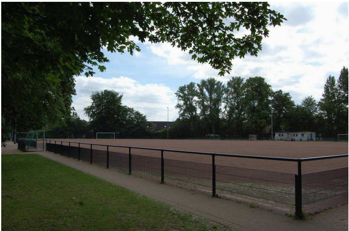
Abbildung 05: Sportplatz/Fußballspielfeld; westliches Sportbegleitgebäude
