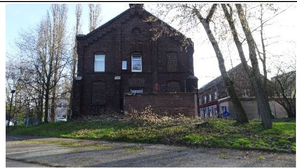
Blick von Westen auf Gebäude Nr. 1
