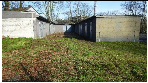
Blick auf nordöstlich gelegene garagenähnliche Gebäude Nr. 5
