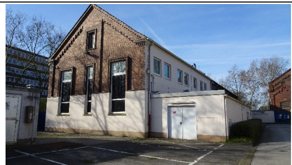
Blick von Osten auf Gebäude Nr. 2
