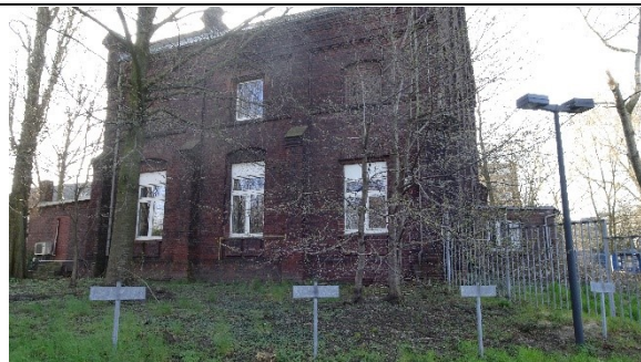
Blick von Norden auf Gebäude Nr. 1
