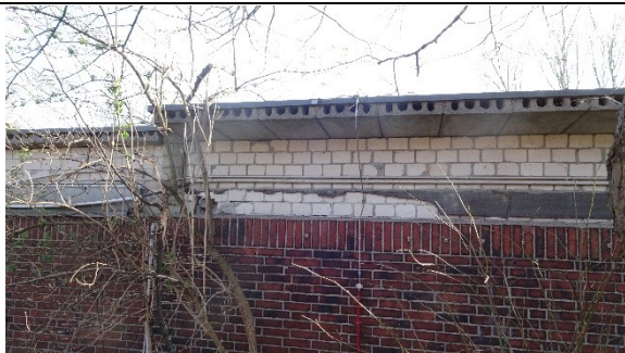
Blick auf Hohlsteine im Dachbereich der garagenähnlichen Gebäude
