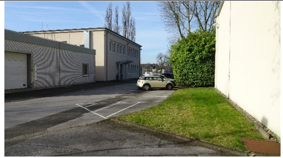
Blick von Osten auf Gebäude Nr. 3
