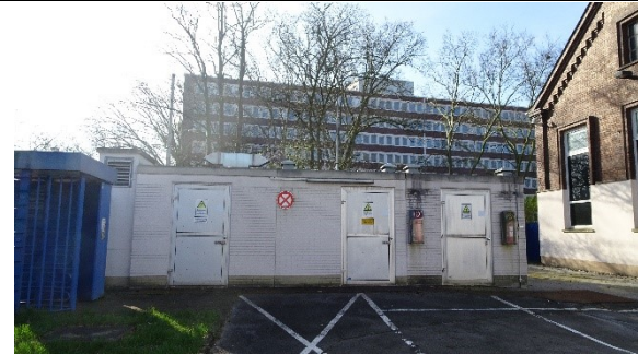
Blick von Norden auf südöstlich gelegenes Trafostation
