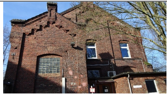
Blick von Osten auf Gebäude Nr. 1
