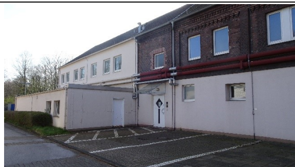
Blick von Norden auf Gebäude Nr. 2
