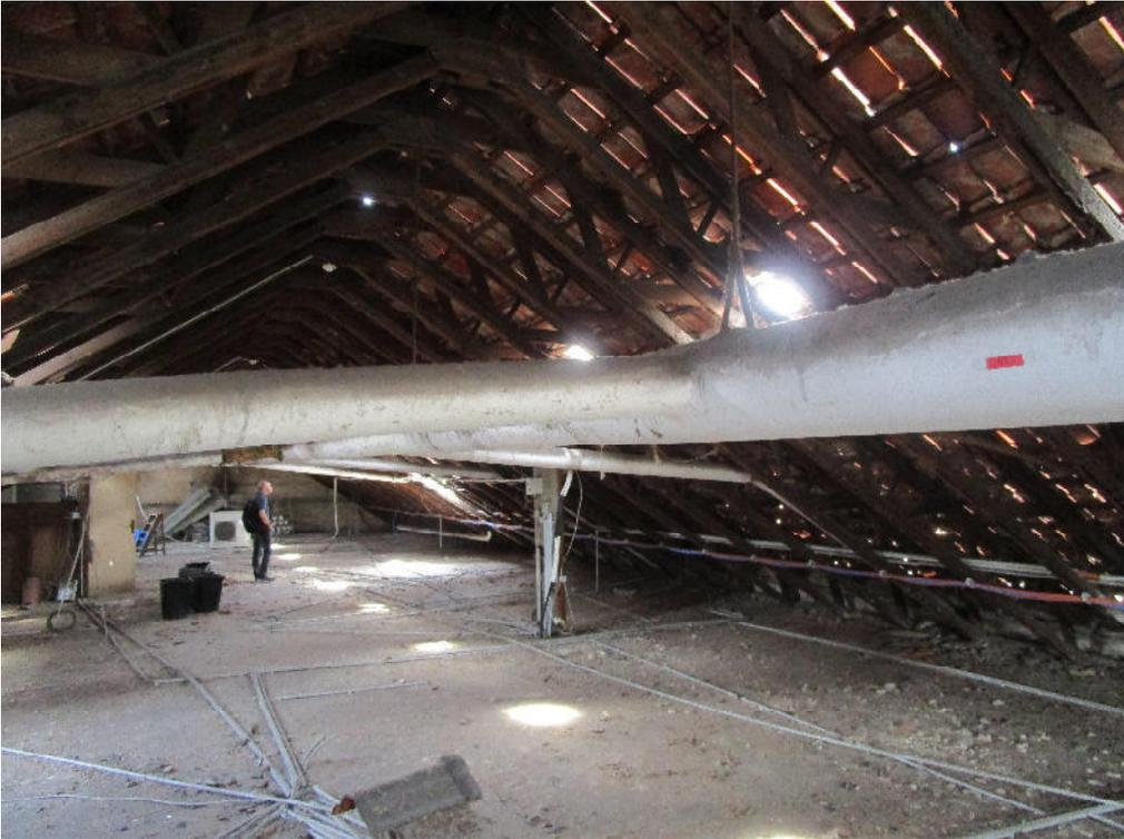
Der große Dachspeicher verfügt über zahlreiche Nischen und Spalten, das Dach ist passierbar. Es gibt keine Wärmeisolierung.
