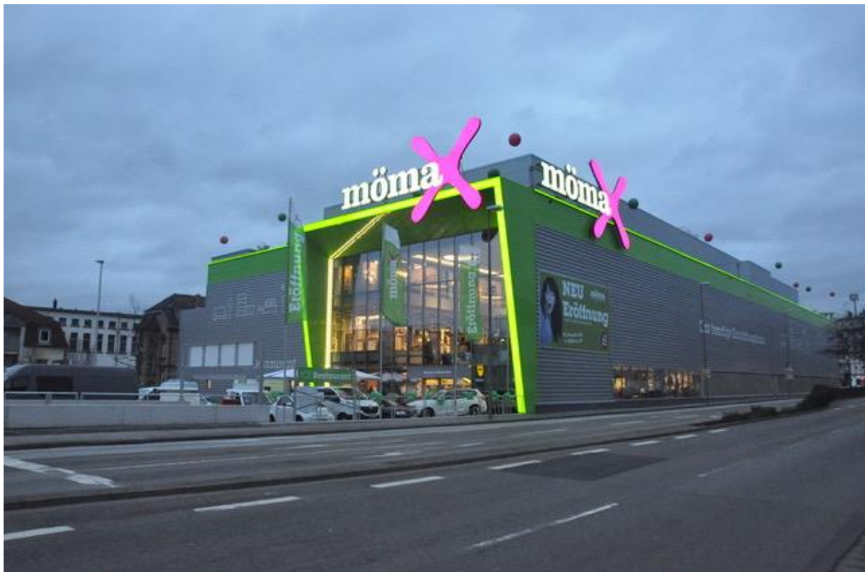
Quelle: Referenzbeispiel mömax Kaiserslautern; mömax Deutschland GmbH
