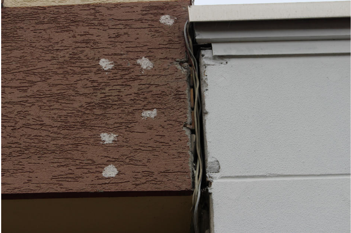
Nischenstrukturen an der Stoßkante zweier Gebäude.....
