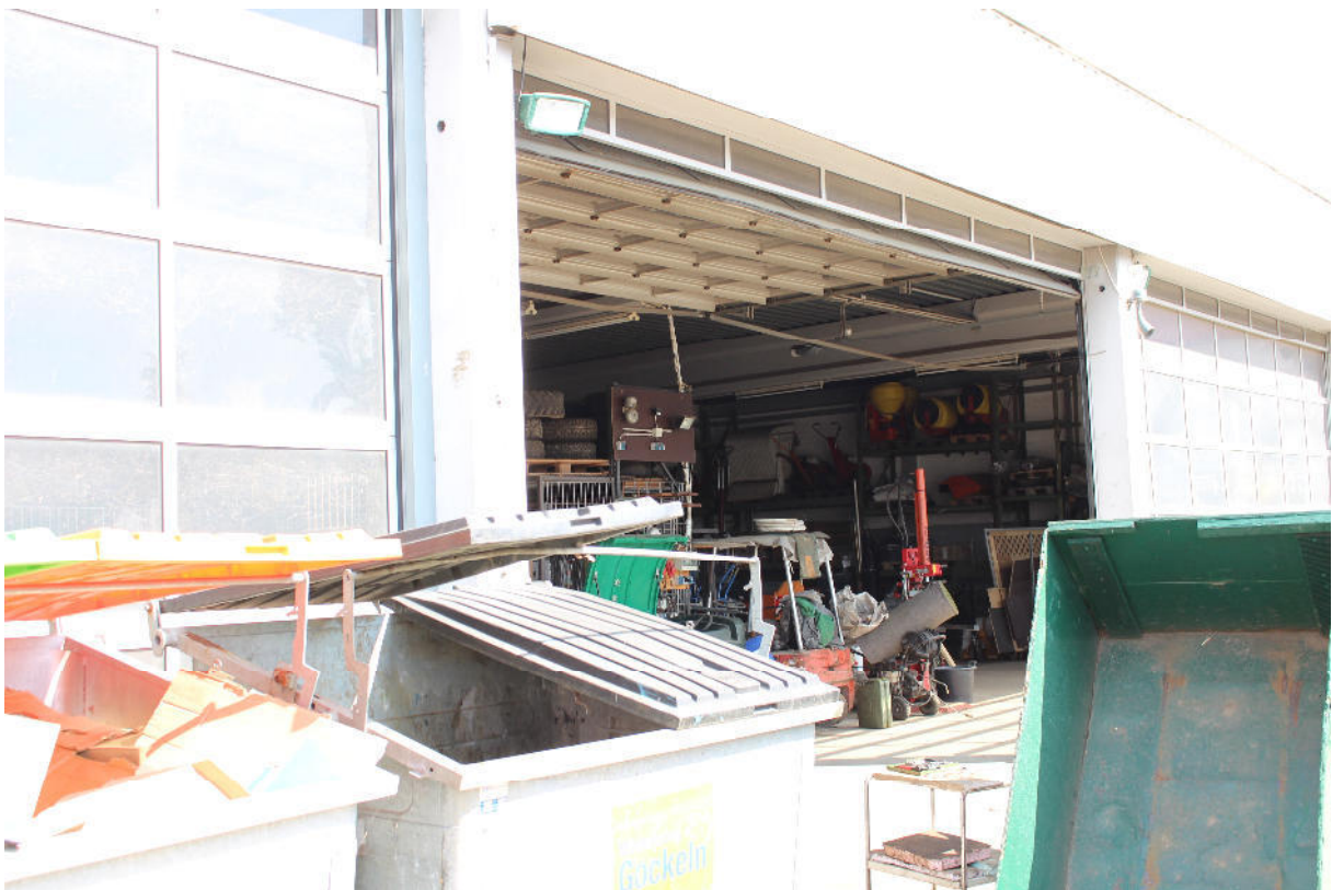
Alle Betriebsgebäude verfügen über Flachdächer und werden noch intensiv genutzt. Sie sind insofern für „Gebäude-Fledermäuse“ unattraktiv.
