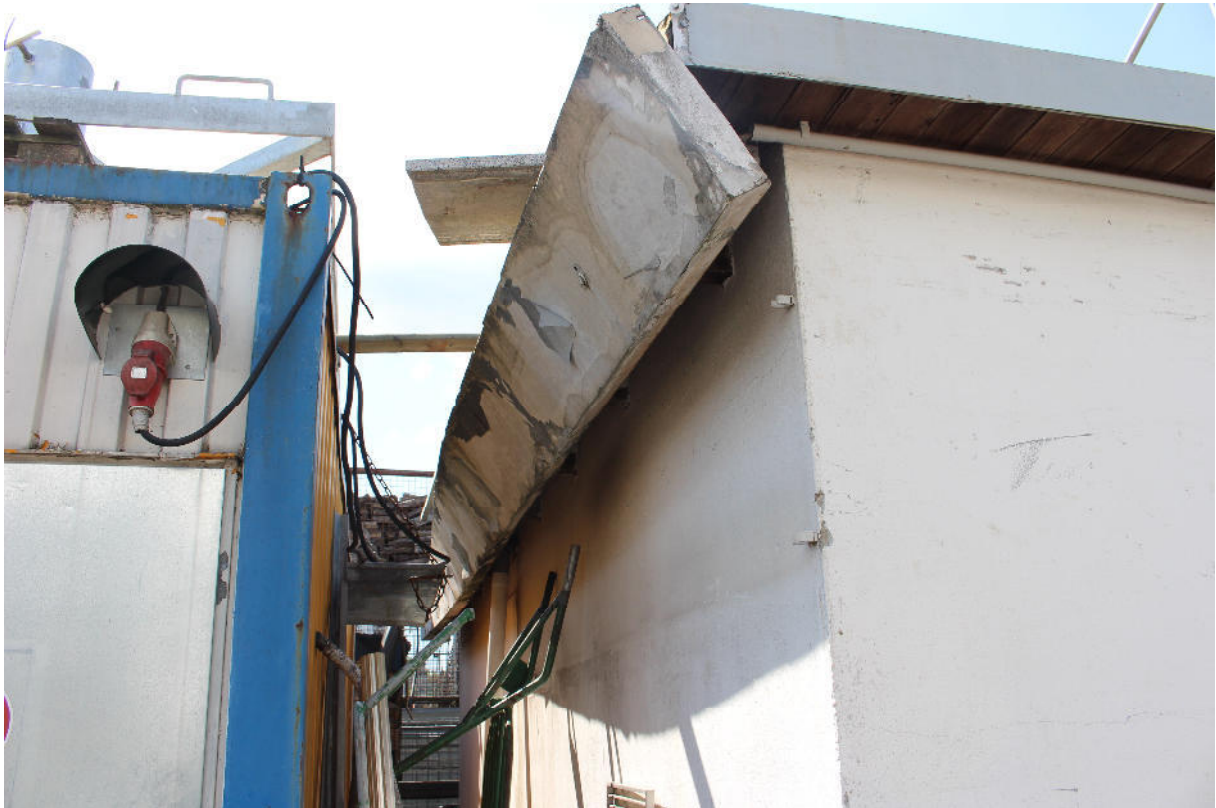
Nischenstrukturen an den Betriebsgebäuden wie hier sind auf dem Betriebshof die Ausnahme.
