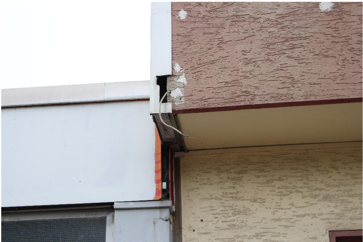
Gebäudeschäden mit potentieller Quartierstruktur für Fledermäuse sind die Ausnahme.
