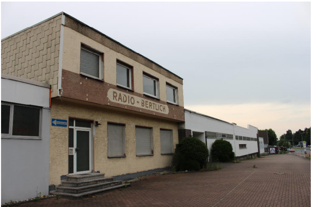
Gebäudefront der Abrissobjekte an der Ostseite
