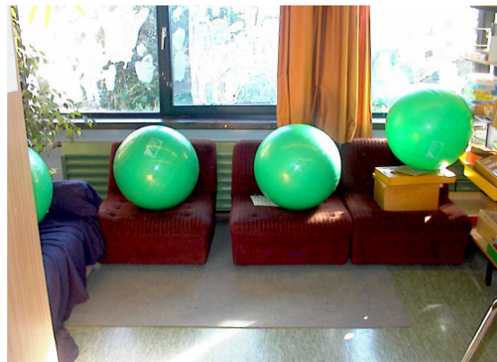
So bitte nicht! Heizkörper müssen frei bleiben.
