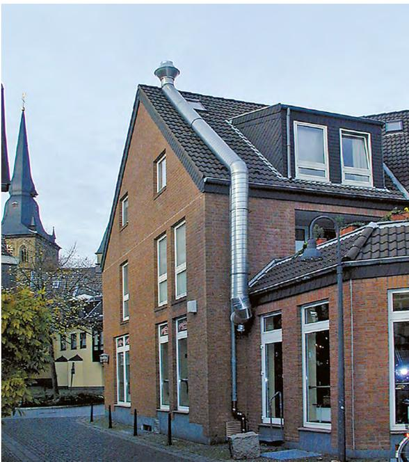
⊖ Negative Auswirkung einer Lüftungsanlage auf das Gebäude
