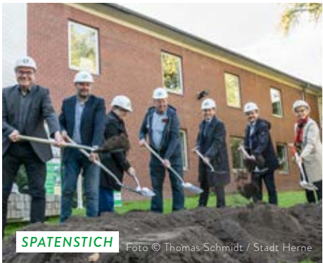
BAUBEGINN Foto © Thomas Schmidt / Stadt Herne
